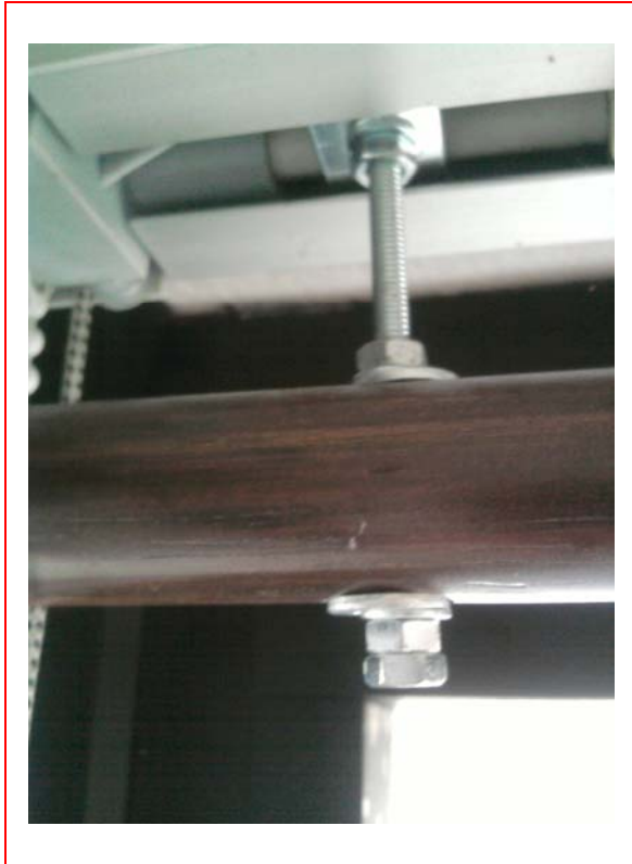
FIGURA 5 FOTO DEL GIUNTO REALIZZATO
