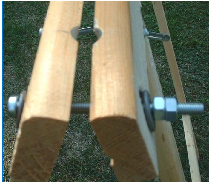
SEDE DI ALLOGGIAMENTO DEL PERNO SUPPORTO E TIRANTI DI REGOLAZIONE CHIUSURA
