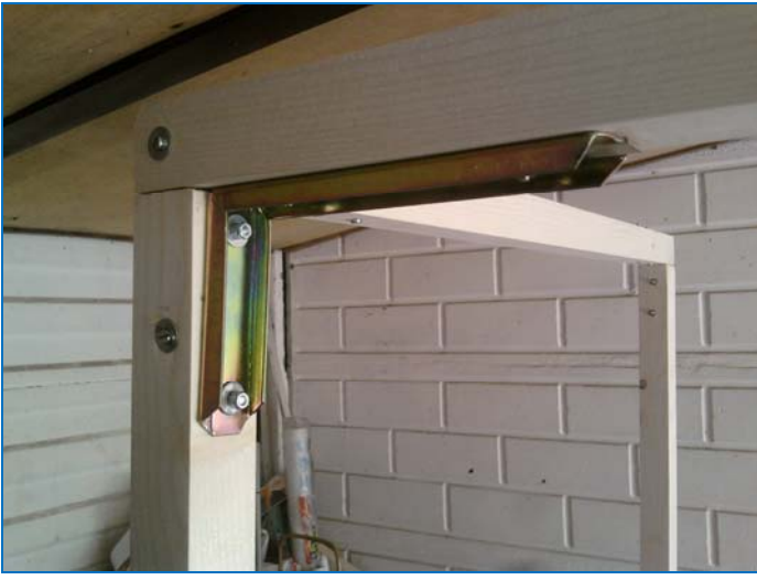
Figura 3 Giunzione palo -traversa
