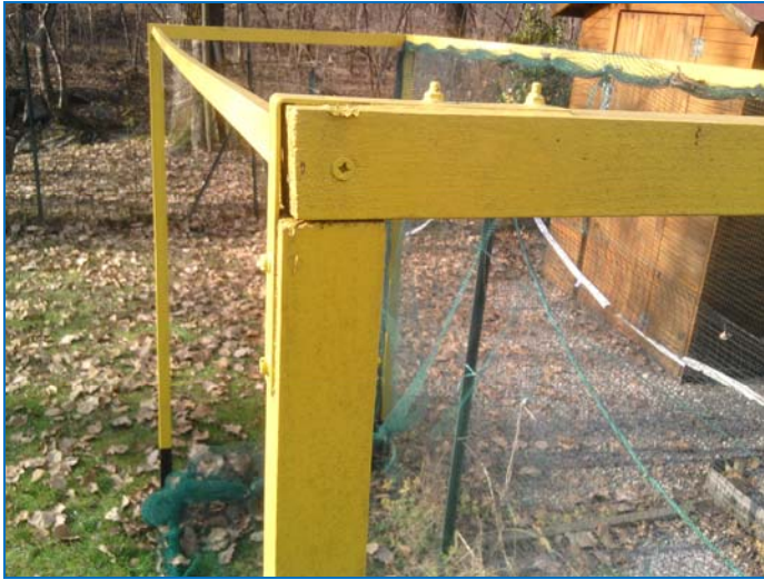
Figura 5 Giunzione supporto alto – supporto verticale
