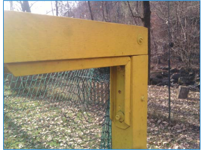
Figura 6 Giunzione palo-traversa
