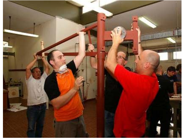
Dopo una passata di antiruggine, la coda viene definitivamente incernierata sul tubo di imbardata ed il tutto viene montato in cima al palo di prova.
