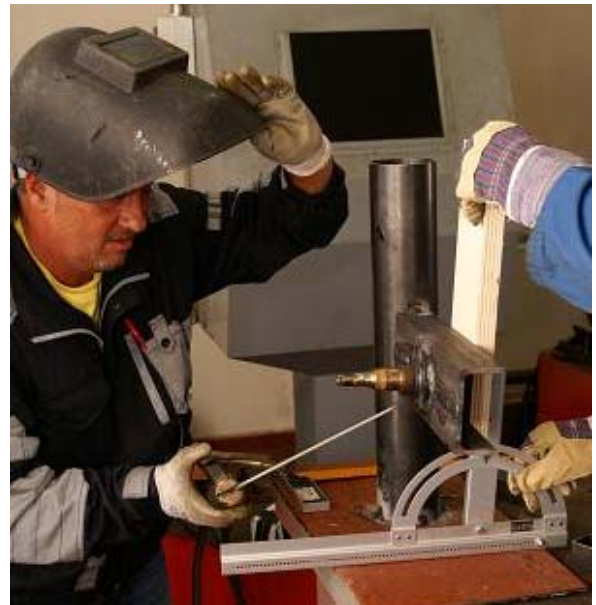
Controllo dell'angolo di 4 gradi per distanziare le pale dal sostegno, prima della saldatura definitiva della staffa sul tubo di imbardata.
