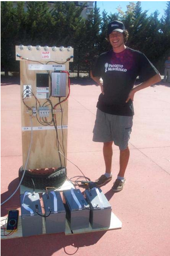
Il pannello è completo e viene collegato alle batterie (n. 4 da 100 Ah) ed al generatore eolico.
